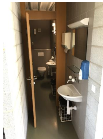
Schmale WC-Anlagen im Lehrerzimmer
