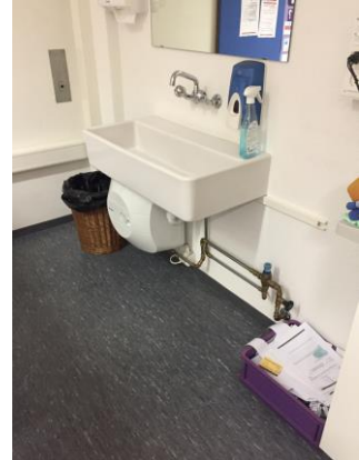
Elektrische Wassererwärmer in Klassenzimmer
