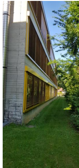
Fensterersatz 1982 (im alten Schulhausteil)
