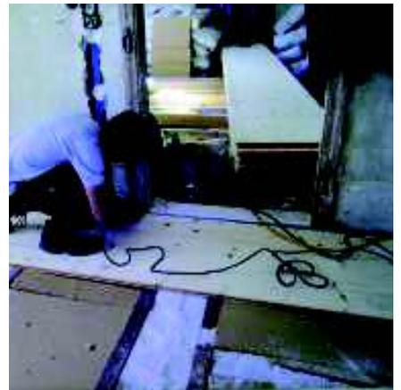
*Neuer Bodenaufbau mit Schallschutzmassnahmen*
